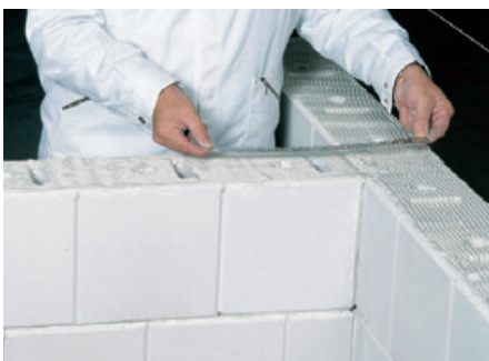
7. Zur Verbindung von Wänden werden Flachstahlanker eingelegt.
