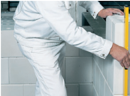
3. Kontrolle mit der Wasserwaage.
