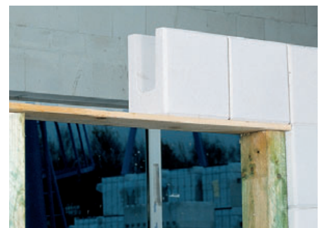
11. Öffnungsüberdeckungen werden mit KS*-Design U-Schalen ausgeführt.
