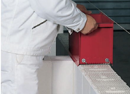
1. Auftragen des Dünnbettmörtels mit dem KS*-Design Mörtelschlitten.
