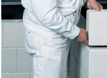
2. Am Wandanfang wird immer ein ganzer oder halber Endstein (einseitig glatt) gesetzt.
