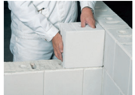
5. Ansetzen des ersten Steins.
