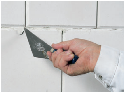
8. Der herausquellende Mörtel muss, damit man ihn problemlos entfernen kann, antrocknen. Erst dann lässt er sich sauber mit der Spitzkelle entfernen.
