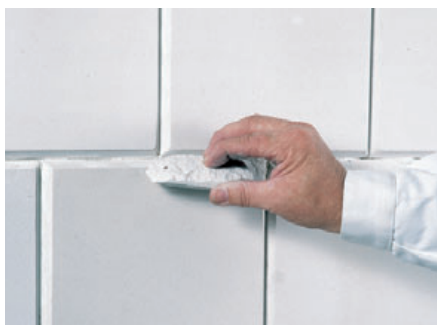
9. Leichte Verschmutzungen lassen sich durch Schleifen mit einem KS* Brocken, bzw. einem Elofix-Stein entfernen.
