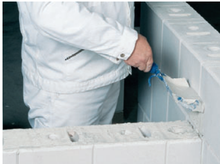
4. Bei Wandanschlüssen wird der Wandanschlussbereich mit angemörtelt.
